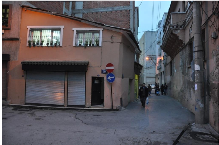
(Hapis edilen mezarın bulunduğu bina)
